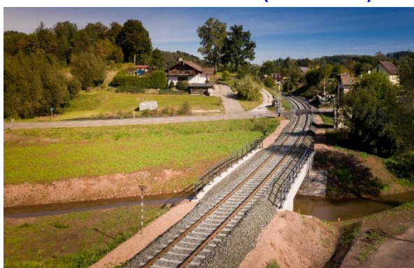
Rekonstrukce mostu na trati Chlumeč nad Cidlinou - Trutnov (Chotěvice)
