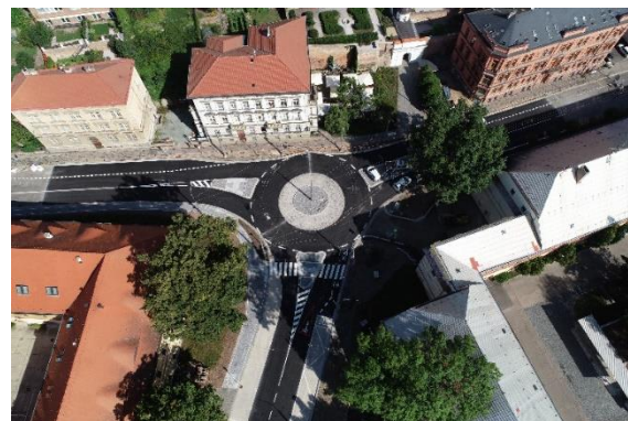
Rekonstrukce křižovatky Fortna a modernizace přestupního uzlu
