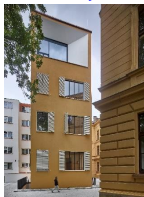
UHK – modernizace a rekonstrukce budovy B
