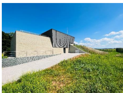
VODÁRENSKÁ SOUSTAVA VÝCHODNÍ ČECHY ZVÝŠENÍ AKUMULACE NA VDJ BOHUSLAVICE
