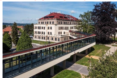
OBLASTNÍ NEMOCNICE JIČÍN NOVOSTAVBA PAVILONU „A“ PRO LABORATOŘE A ONKOLOGII
