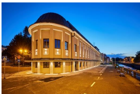
REKONSTRUKCE KINA VESMÍR V TRUTNOVĚ
