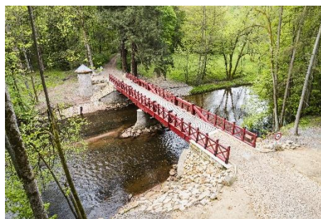
REKONSTRUKCE MOSTU ČERVENÝ MOST, ŽERNOV
